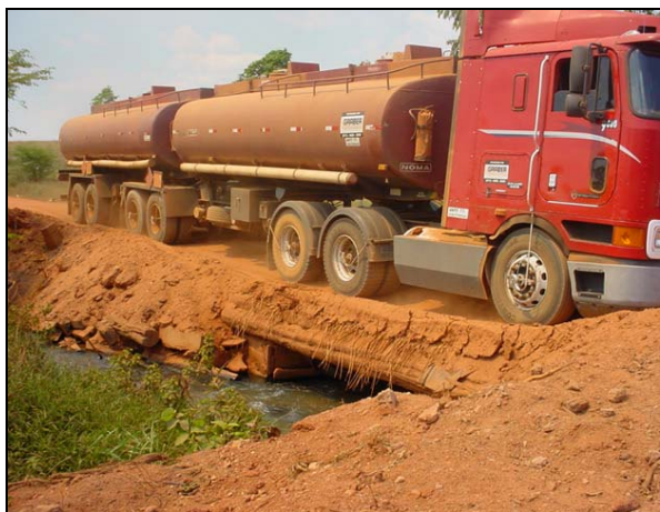
Figura 8-5 - Exemplo dos tipos de veículos biarticulados e as estruturas de desvio utilizadas na BR-158 - Desvios atuais.
